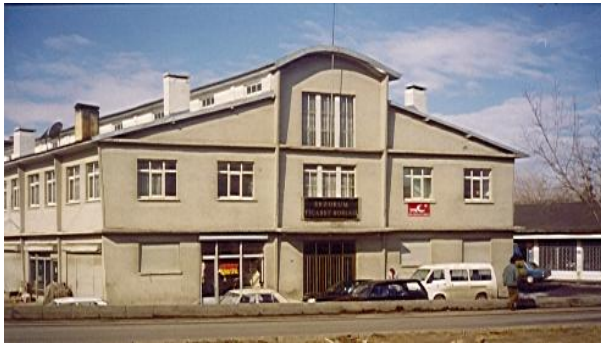
Borsamız Merkez Binası Eski Hali
