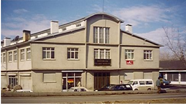
Borsamız Merkez Binası Eski Hali
