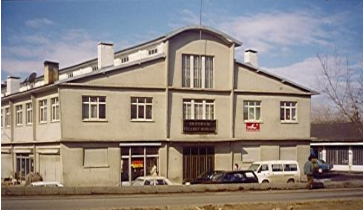
Borsamız Merkez Binası
