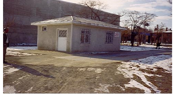
Borsamız Sebze Hali Kantar Binası
