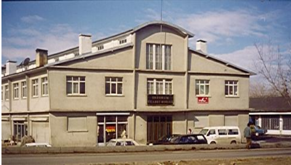
Borsamız Merkez Binası Eski Hali
