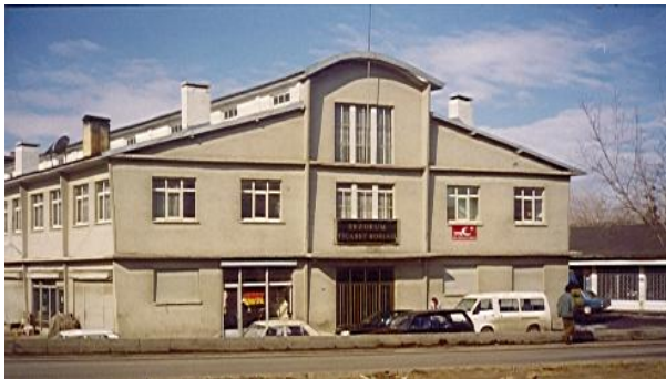
Borsamız Merkez Binası Eski Hali
