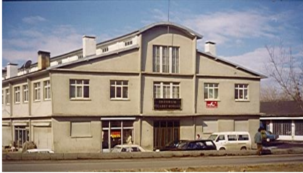
Borsamız Merkez Binası Eski Hali
