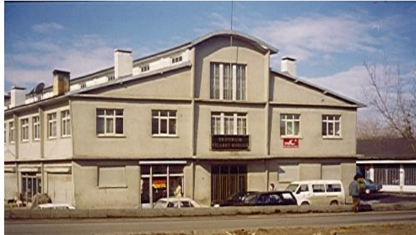
Borsamız Merkez Binası Eski Hali
