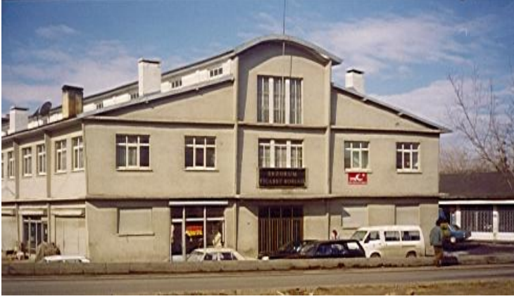
Borsamız Merkez Binası
